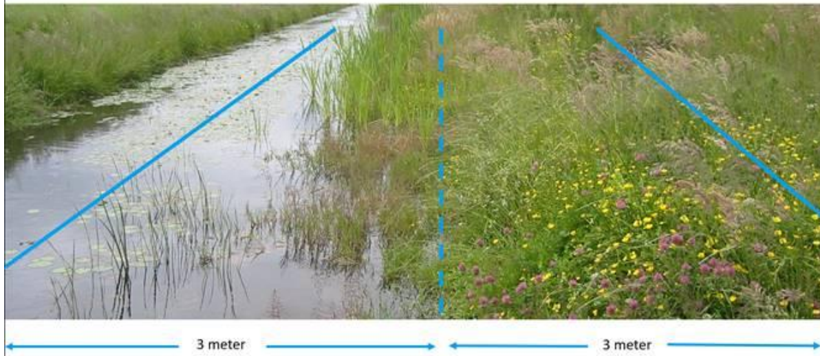
Figuur 31 Maatvoering natuurvriendelijke oever, met zowel een deel boven water (3m) en een deel onder water (3m). Foto: Bart Specken.
